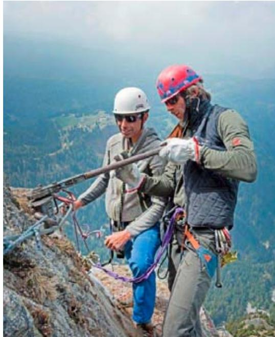
Mehr als 500 Löcher mussten von Peter Vanzo und seinen Bergführern ins Gestein gebohrt werden, um mit Haken das über 1.000 Meter lange Stahlseil zu fixieren
