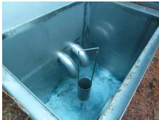
In Behältern aus Innoxstahl wird das Quellwasser gesammelt und von dort in einer 4,3 km langen Druckrohrleitung zum 450 m tiefer liegenden Speicher Hasenegg geleitet
