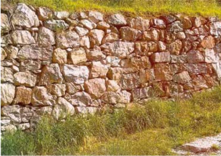
turgrund abgegrenzt sind. Im Fundamentbereich wurden immer etwas größere Steine genommen, jedenfalls nur was eine Person zu heben vermag. Nur wenn ein feuchter und unstabiler Grund vorhanden ist, kann von Fall zu Fall ein Betonfundament errichtet werden, das aber nicht sichtbar sein soll. Zweckmäßig wäre, wenn mehrere Laufmeter betroffen sind, den Sachbearbeiter zu fragen. Der Beitrag ist pro qm Sichtfläche € 45.-
