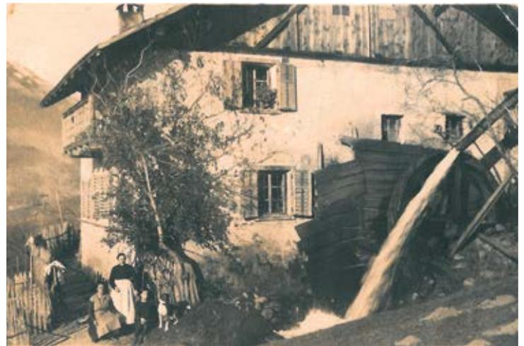
Früher wurde das Wasser aus den Waalen nicht nur zur Bewässerung der Felder, sondern auch zum Antrieb der Mühlräder abgeleitet. Die Hartlmühle Ende der 1940er Jahre
