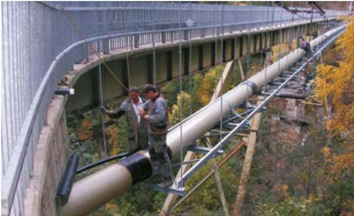
*Beim Bau der E-Werke mussten mehrere technische Herausforderungen bewältigt werden, wie z.B. der Bau einer Rohrseilbrücke über die Masulschlucht.*
