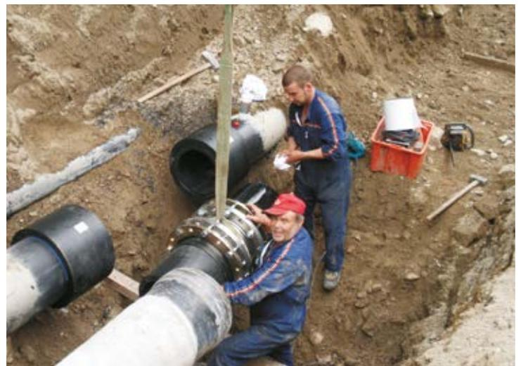
Dank der Erfahrung einheimischer Firmen im Kraftwerksbau konnten für alle technischen Schwierigkeiten gut durchdachte Lösungen gefunden werden. Im Bild der Einbau einer dehnbaren Rohrverbindung.
