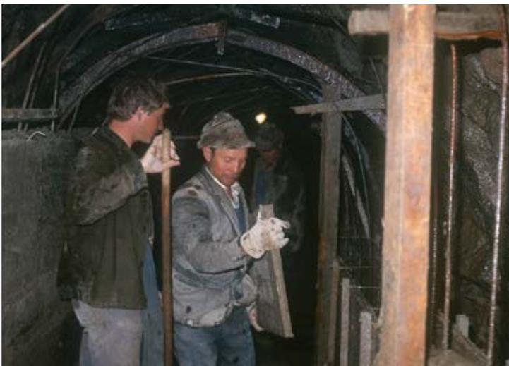
Das letzte Teilstück des Stollens, das im Jahr 1980 errichtet wurde, erhielt 1982 eine Einwölbung aus Stahlbeton.
