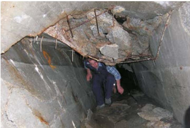
Durch den Bergbruch im felsigen Gelände ist die Auskleidung des Tunnels teilweise zusammengebrochen.
