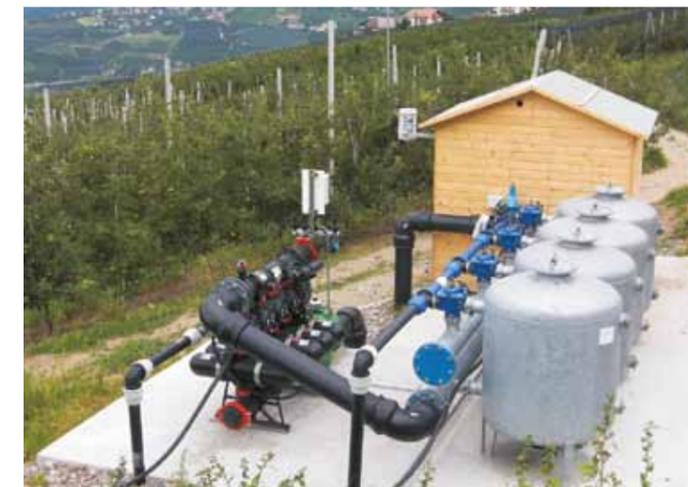
An Filterstationen wird das Waalwasser gefiltert und fließt dann in die Tropferleitungen; im Bild die Filterstation am Hinteren Goyen
