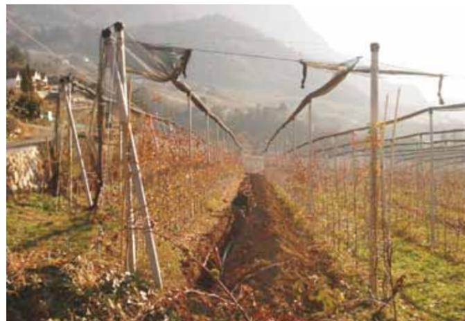
Über 32 km lang sind die Rohrleitungen, die für die neue Tropfbewässerungsanlage vom Neuwaal aus durch die Obstwiesen von Schenna verlegt werden mussten
