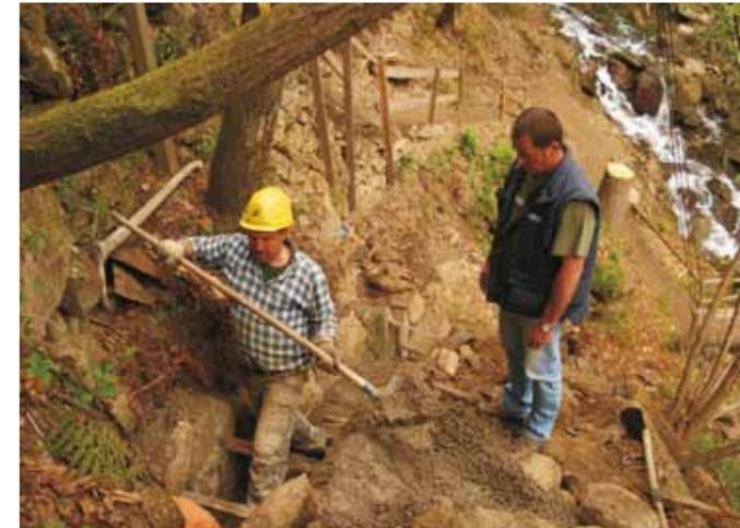
Die Grabungsarbeiten wurden teils mit Baggern, teils aber auch von Hand und in schwierigem Gelände durchgeführt...
